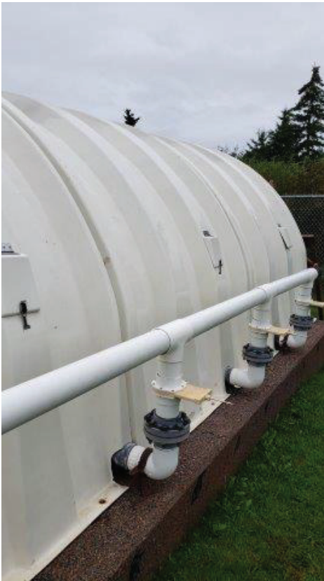
B9: De-sludging header
